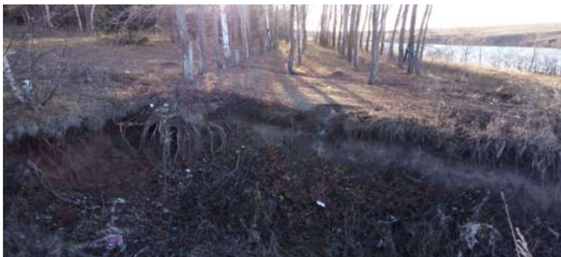
Рис.4.1 Разрушение берегов в средней части оврага
