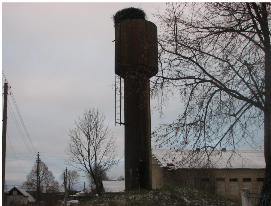
Рисунок 17 – Измерение основания водонапорной башни Слепневым Михаилом (до стыковочного шва 1м). Съемка 20.11.2018 (автор снимка Филиппова Р.В.)
