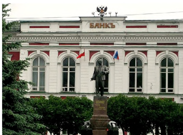
Здание банка, ул. Б. Московская
