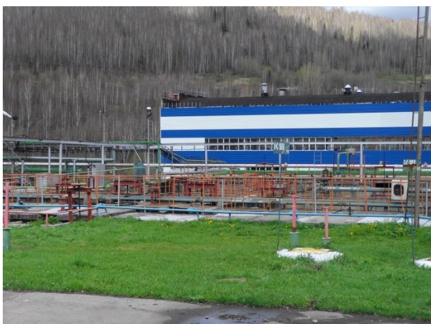
Рис.6 Блок ёмкостных сооружений БОС г.Губаха
