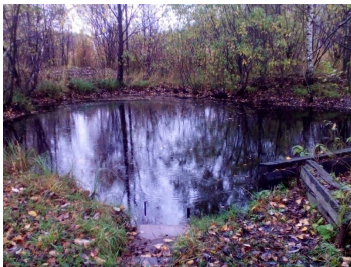
Рис. 11. Пожарный водоемов пос. Лямино
