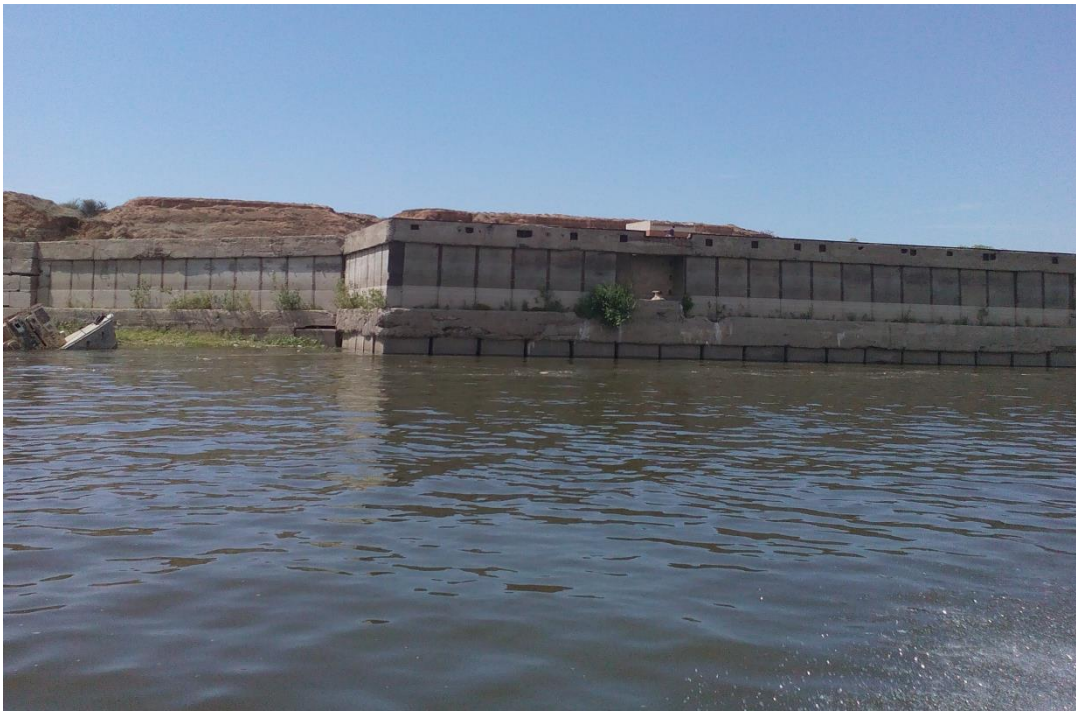
Рис.25. Бетонный причал. Фото автора.
