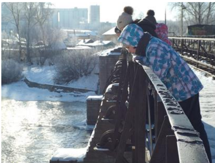
Рис. 17. На старой плотине. 17.02.19 г.
