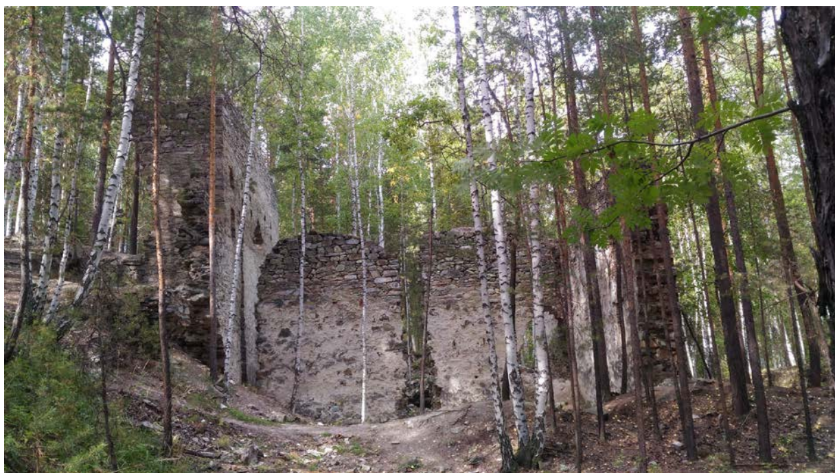
Рис.1. Развалины строений обогатительной фабрики
