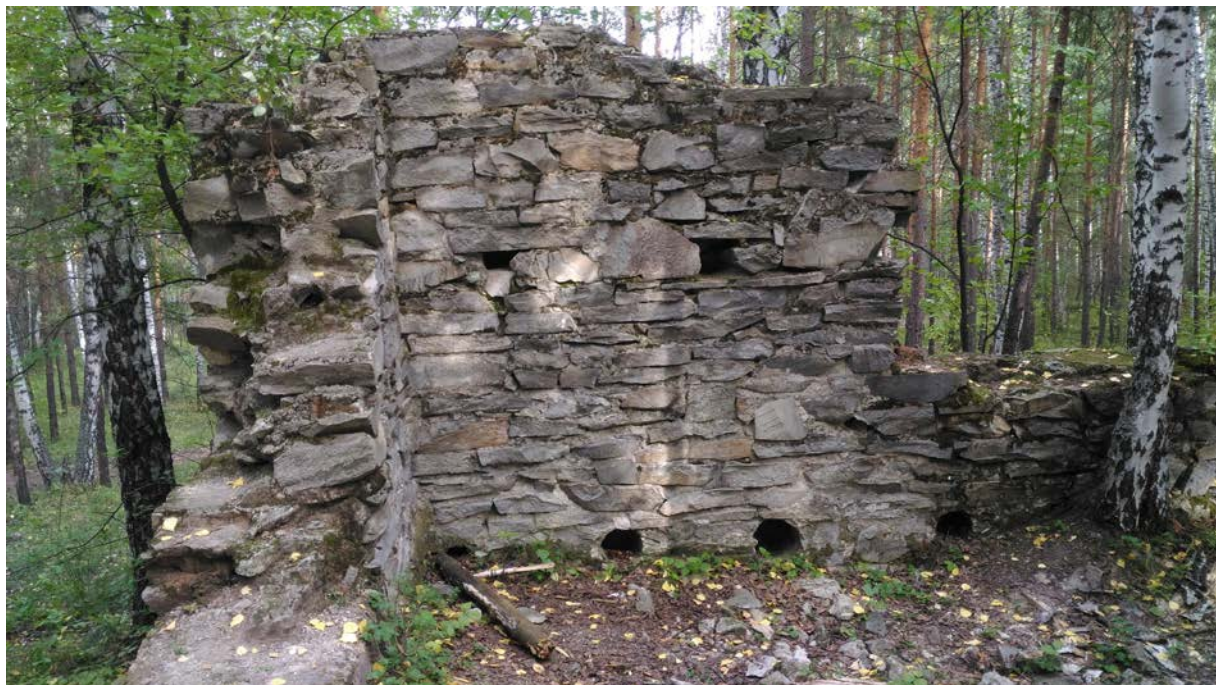
Рис. 2. Развалины строений обогатительной фабрики
