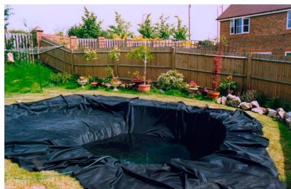
Рисунок 4. Создание пруда на основе полимерной пленки.
