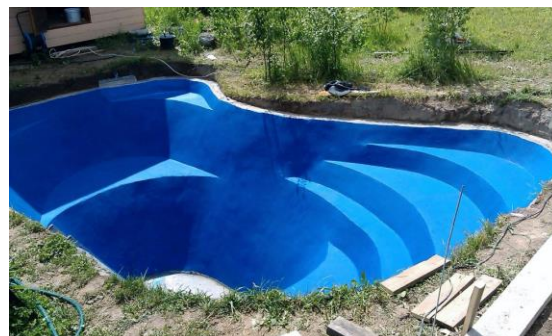
Рисунок 3. Окрашенная для гидроизоляции бетонная чаша пруда.
