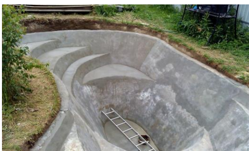
Рисунок 2. Бетонная чаша пруда.
