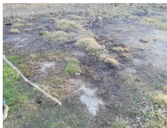
Рис. 2.13 – Состояние дорожек парка
