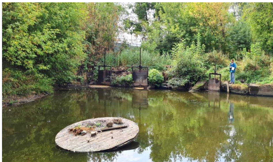
Рис. 2. Гидротехнические сооружения на Монастырской протоке
