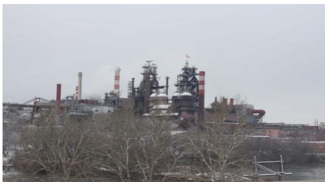
Рисунок 2. ОАО «Косогорский металлургический завод»
