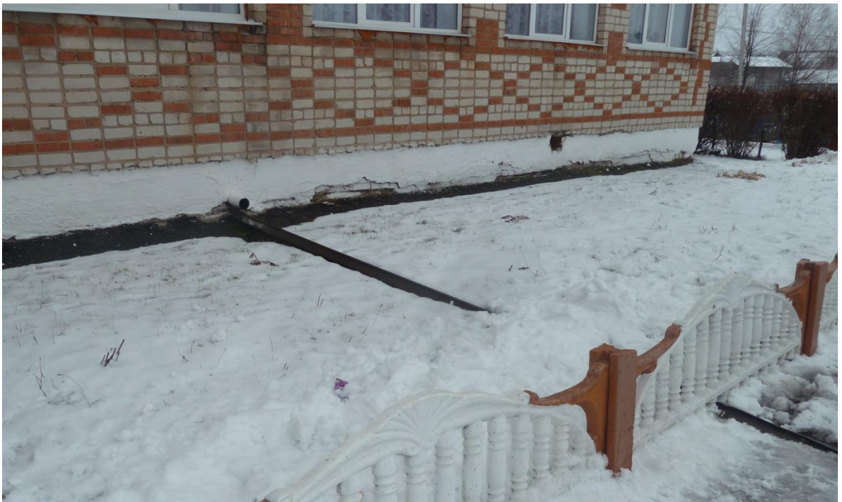
Фото 2. Нижний слив с желобом для отвода воды от здания.
