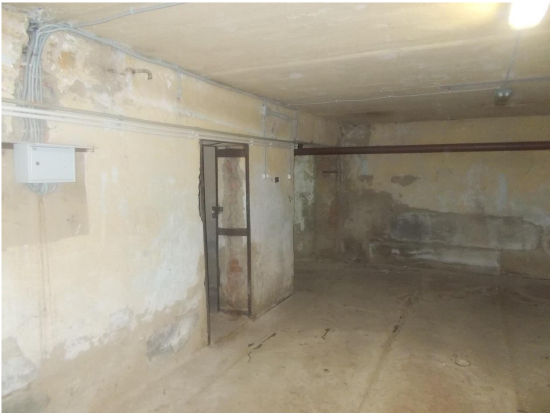
Фото 6. Дверные проемы в подвале.
