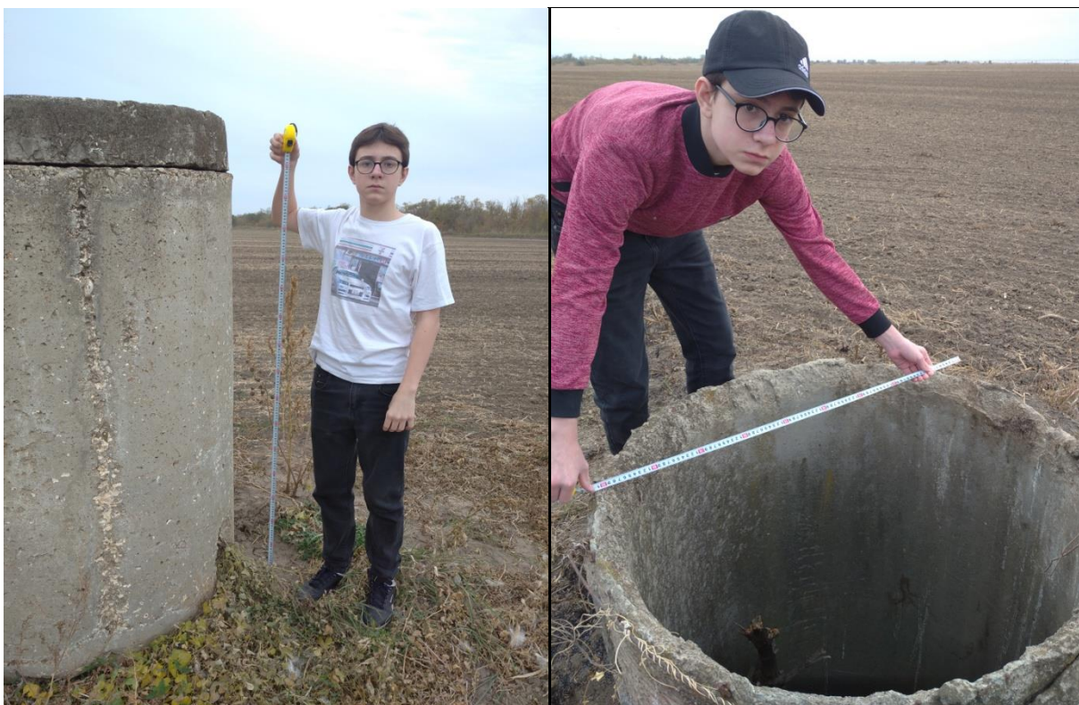
Рисунок 16, 17. Измерение параметров смотровых колодцев
