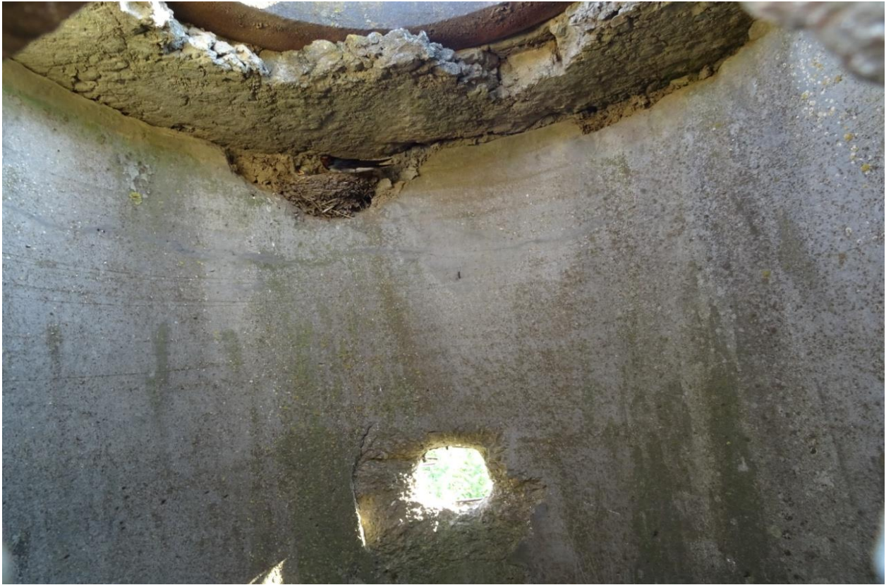
Рисунок 3. Гнездо в смотровом колодце под крышками-перекрытиями
