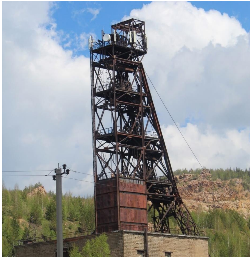
Рисунок 11. Надшахтная постройка шахты «Сидеритовая»
