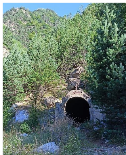
Рис.5 Фото водоотводной штольни в п. Садон
