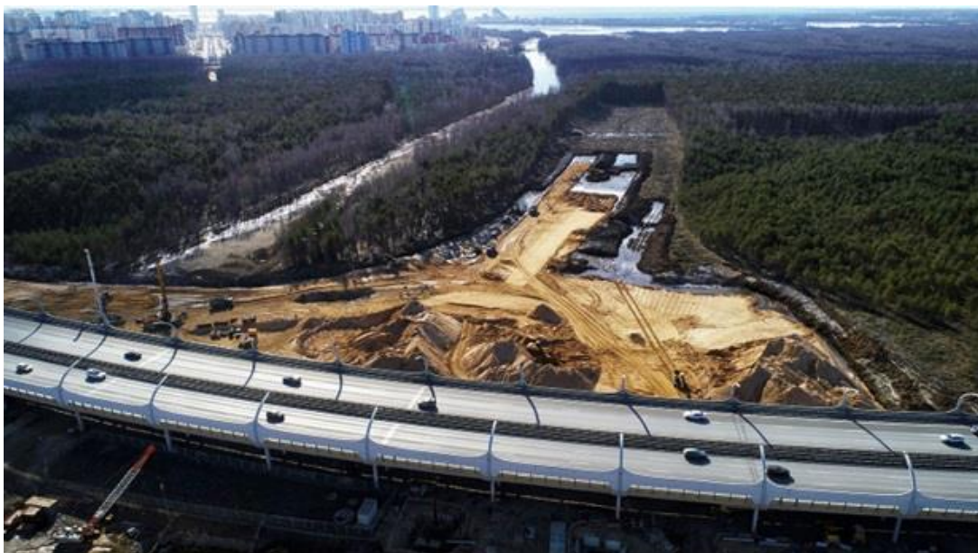
Рисунок 3. Строительство Шуваловской развязки автомобильной магистрали «Западный скоростной диаметр», г. Санкт-Петербург. Фото из открытых источников.
