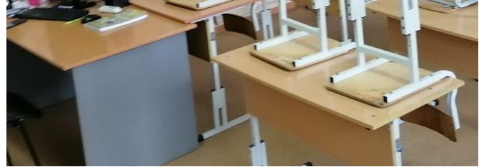
Фото 2. Покрытие полов линолеумом
