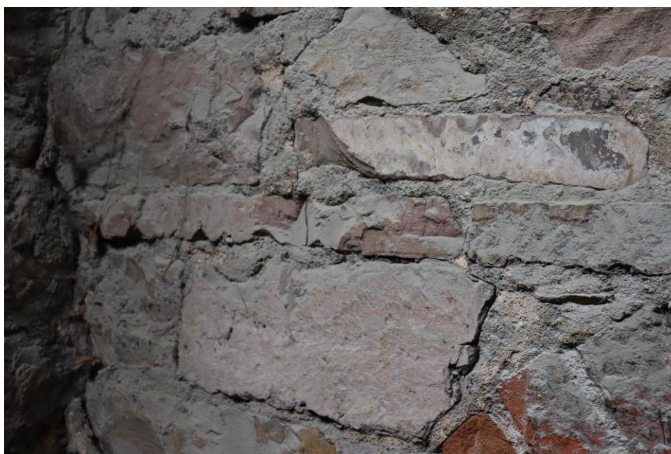
Рисунок 15. Стены зданий у Порожской ГЭС
