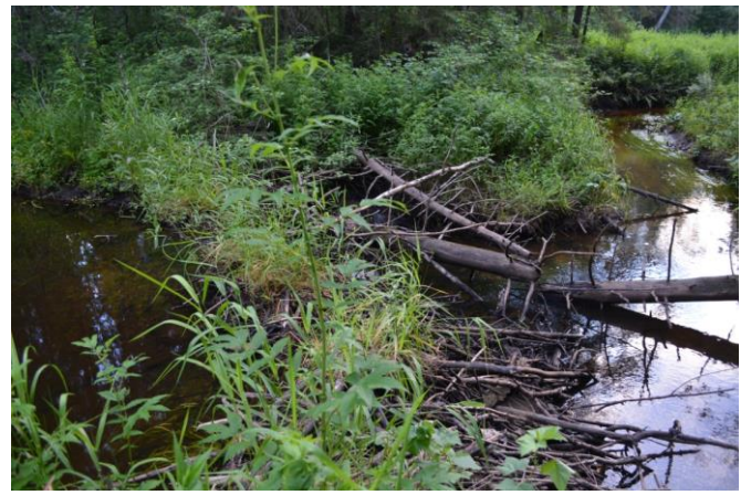
Рис. 4 Вид на плотину сверху
