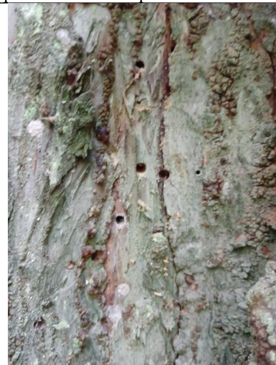
Отверстия в морозобойной трещине , площадка №3, дерево 3'
