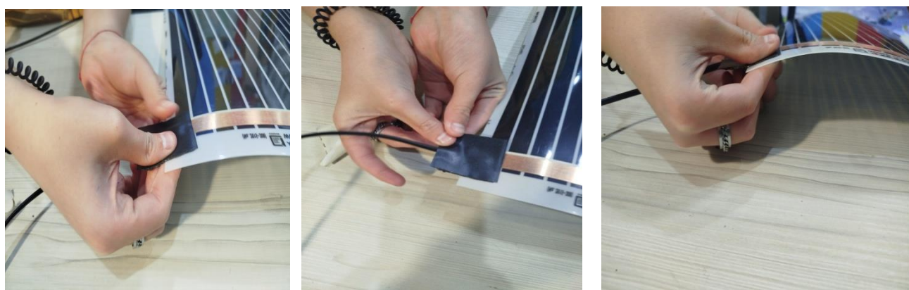
Рисунок 7. Изоляция клеммы
