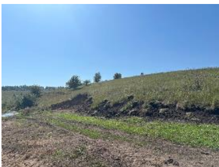
Рис. 16-18. Прокладка несанкционированных дорог приводит к оползням, образованию оврагов и усиливает эрозию почвы
